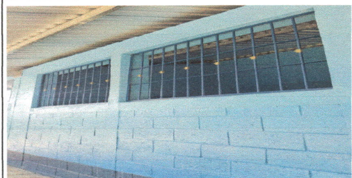
Foto 3: Se observa la fotografía la instalación de los balcones de las ventanas de la escuela.
