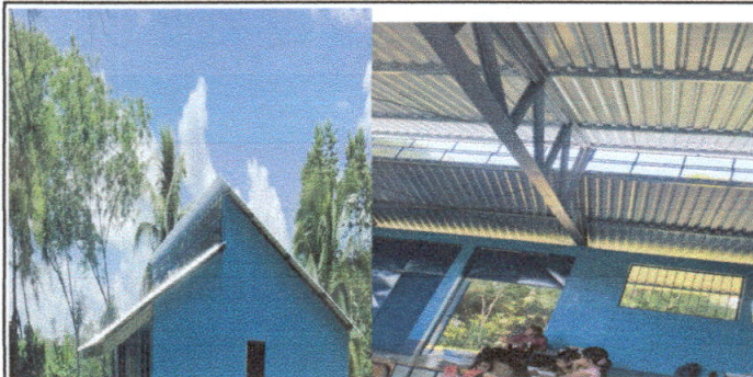
Foto 1: Se observa en la fotografía la instalación de la estructura metálica y el techado de la escuela.
