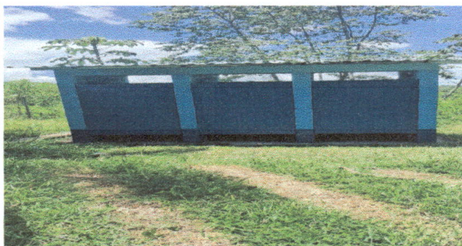
Foto 4: Se observa en la fotografía la instalación del techado, puerta y pintura del baño.
